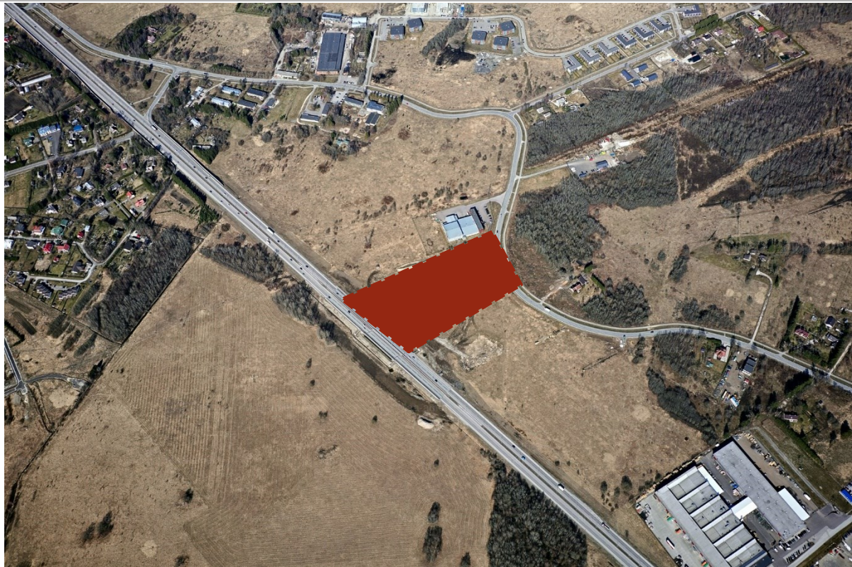
Joonis 1. Vaade planeeritavale alale (aerofoto, Maa-ameti fotoladu 2023-04-10)
